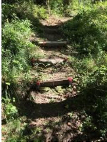
林内作業道の整備:一部腐食した 階段の取り換え作業を実施。
