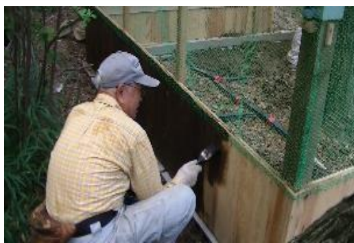
柱及び腰板の防腐塗装
